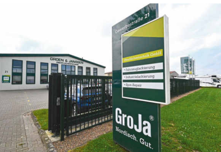
Nahe des Groen & Janssen-Firmensitzes in Georgsheil wurde für die Oberflächentechnik ein geeignetes Objekt gefunden und in Rekordtempo zum Lackier- und Karosseriebetrieb umgebaut. (Foto: M. Rehm)
